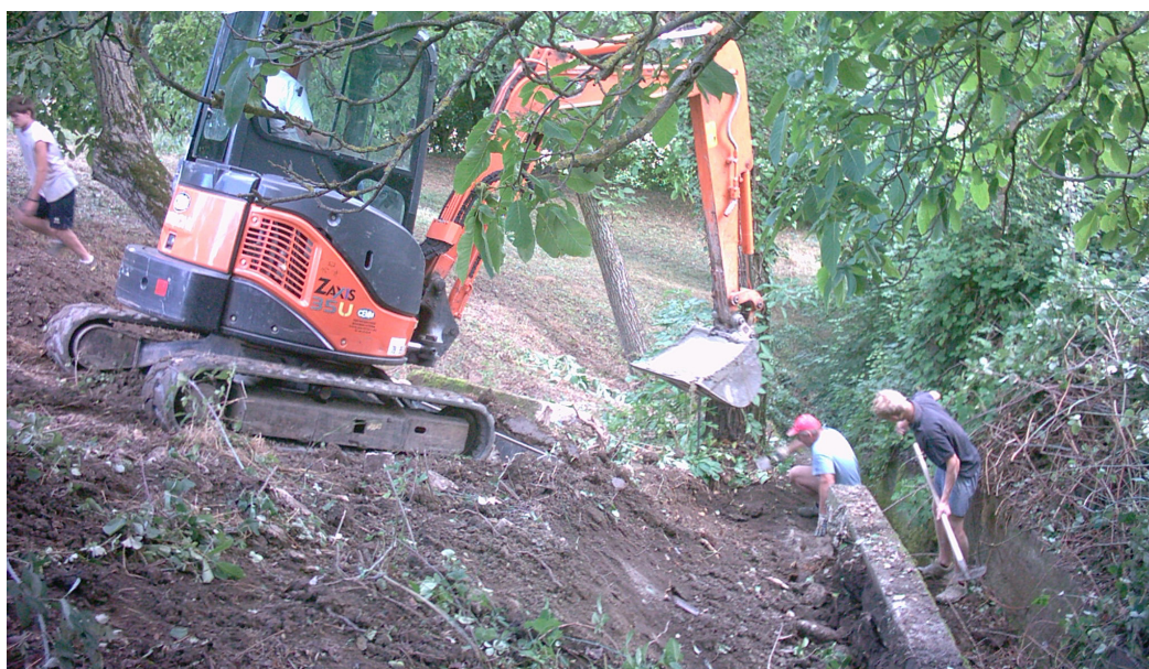
Figura 4.9 Fotografia del Cunettone durante lavori di manutenzione straordinaria a cura della Regione Emilia Romagna nel luglio 2009.
