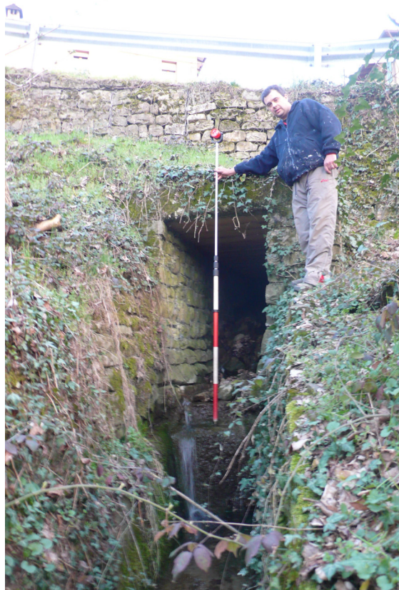
Figura 4.11 Fasi del rilievo strumentale. Con il prisma ottico in prossimità della zona di presa.
