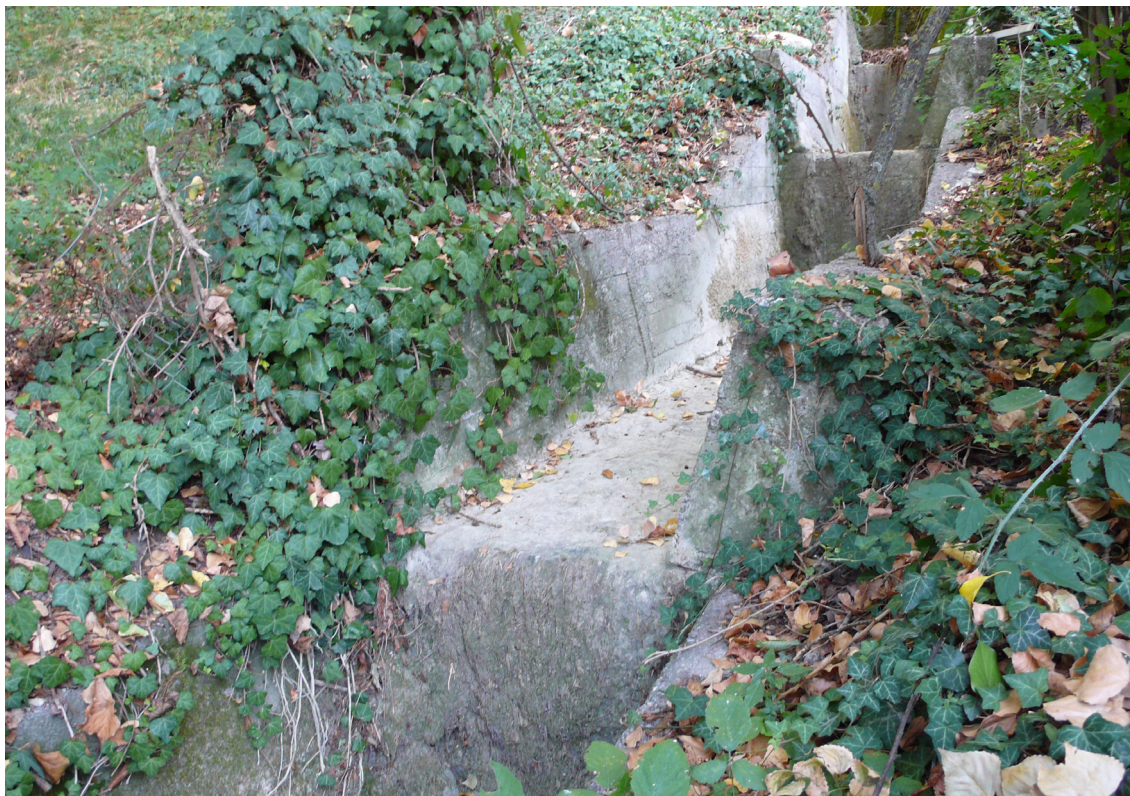
Figura 4.3 Fotografia delle opere di contenimento in calcestruzzo realizzare nel '74. Fotografia realizzata nel periodo estivo.
