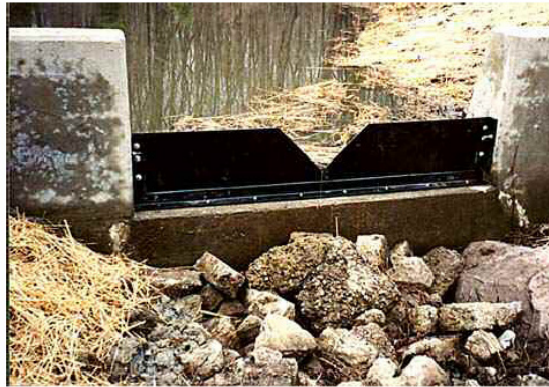
Figura 1.7 Foto di un tipico stramazzo triangolare inserito in un torrente montano.
